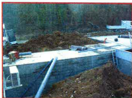
Chantier sale et remblais pas faits
